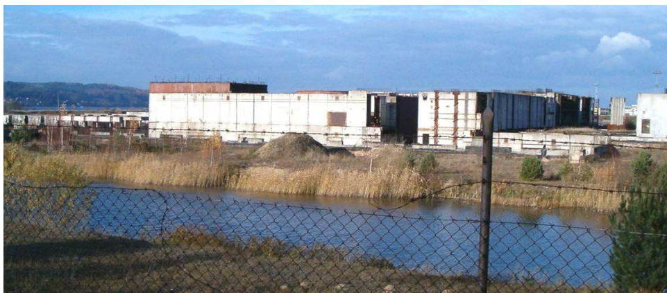
Rys. 7. Widok na budynki reaktorów i maszynowni EJ „Żarnowiec” od strony południowej.
