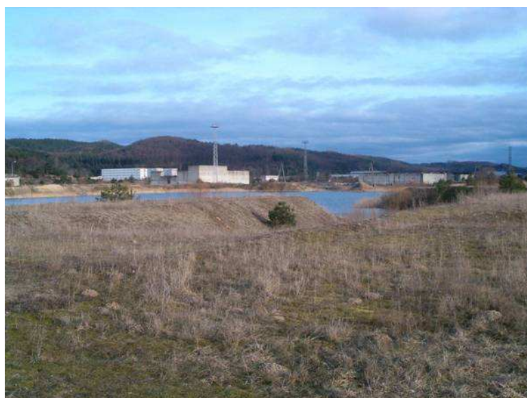
Rys. 9. Fragment terenu potencjalnej lokalizacji nowej EJ „Żarnowiec”.
