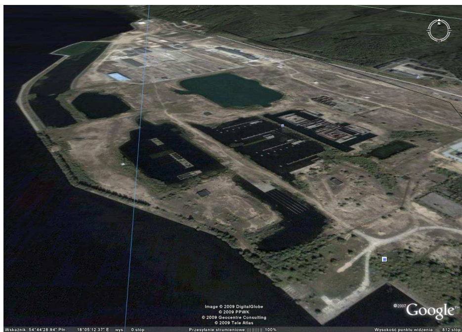
Rys. 4. Rejon głównych obiektów byłej EJ „Żarnowiec” w budowie.
