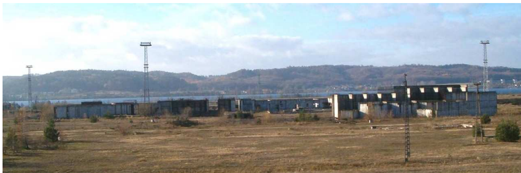
Rys. 6. Rejon głównych obiektów byłej EJ „Żarnowiec” w budowie – na pierwszym planie budynek gospodarki odpadami promieniotwórczymi dalej budynek reaktorów.
