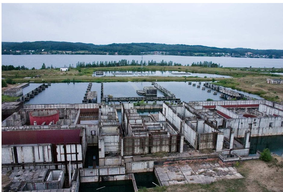
Rys. 5. Rejon głównych obiektów byłej EJ „Żarnowiec” w budowie – na pierwszym planie budynek reaktorów, dalej maszynownia i centralna pompownia wody chłodzącej (autor zdjęcia: Michał Kotas, zaczerpnięto z: http://www.atom.edu.pl ).
