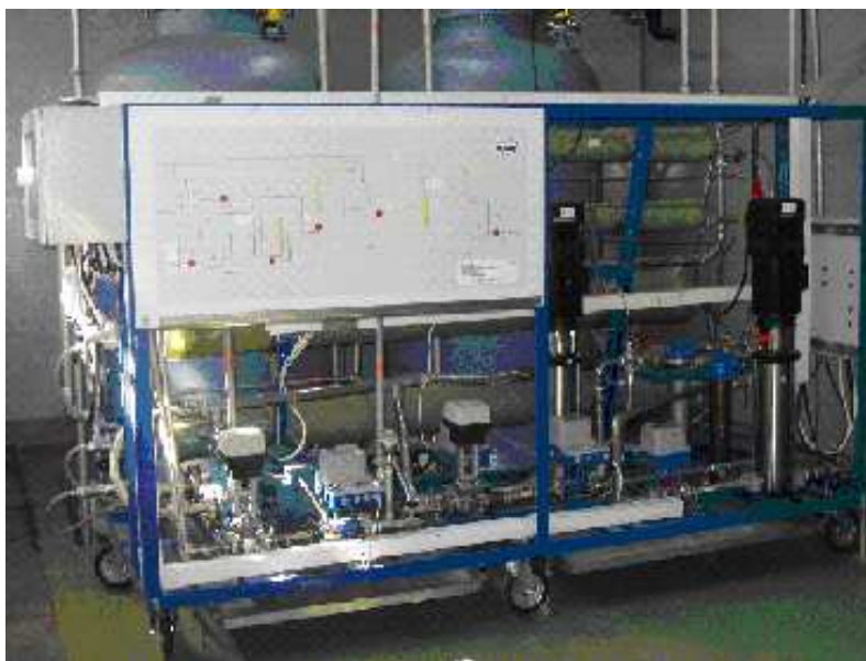
Rys. 9. Instalacja odwróconej osmozy.
