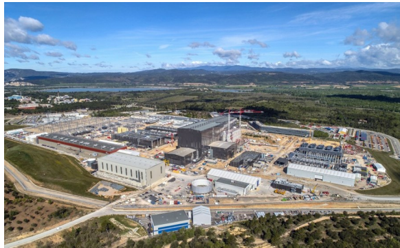
Rysunek 3.6: Widok na plac budowy tokamaka ITER. Źródło: [22]
