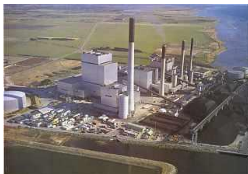
Rysunek 10 - Elektrownia węglowa [22]
