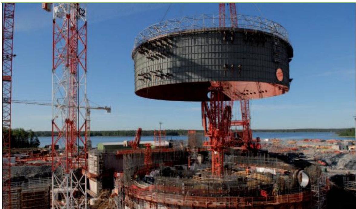
reaktor typu EPR o mocy 1 600 MWe podczas budowy w Olkiluoto (Finlandia ), stan z lipca 2007
