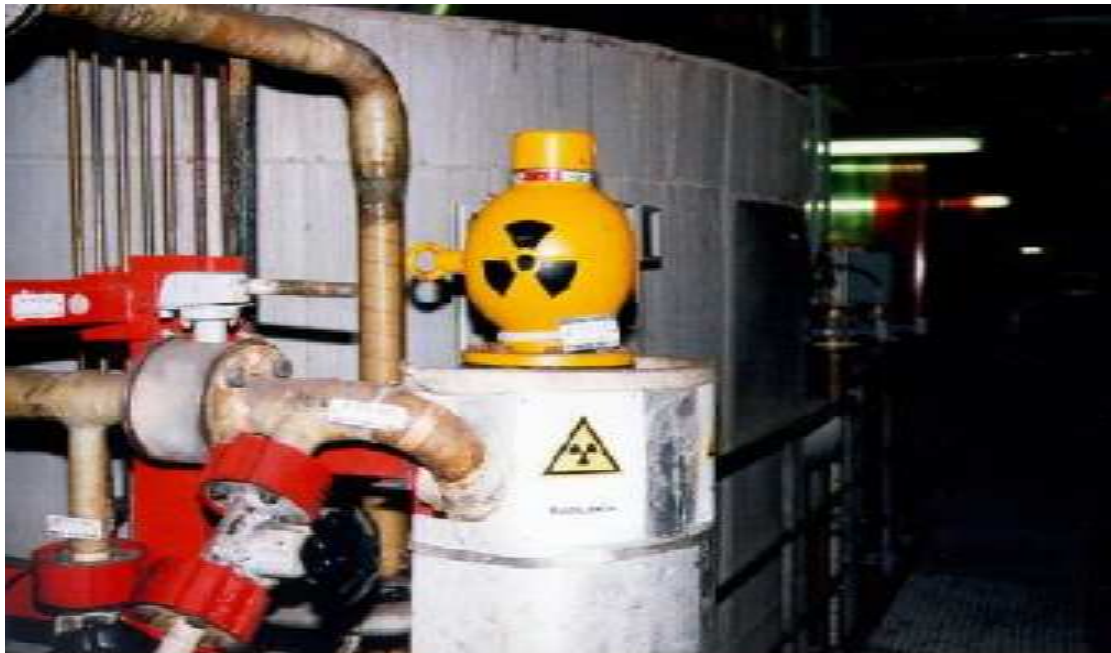
Rys.10. Bezinwazyjny pomiar gęstości mleka wapiennego do oceny efektywności oczyszczania gazów spalinowych [8]
