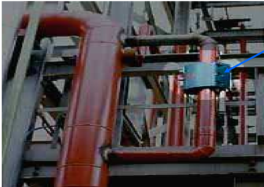
Rys .25 Przemysłowa aplikacja pomiaru wodoru na instalacji produkcji kwasu siarkowego [7]
