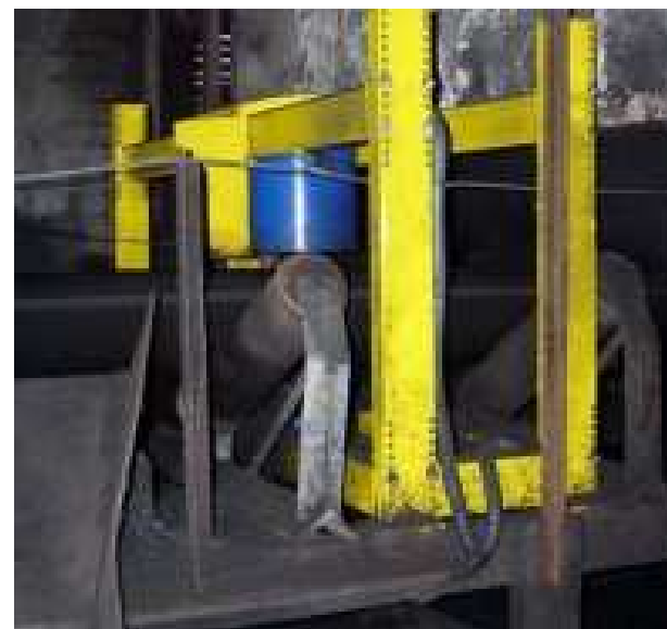
Rys.22. Układ pomiarowy zamontowany nad przenośnikiem taśmowym
