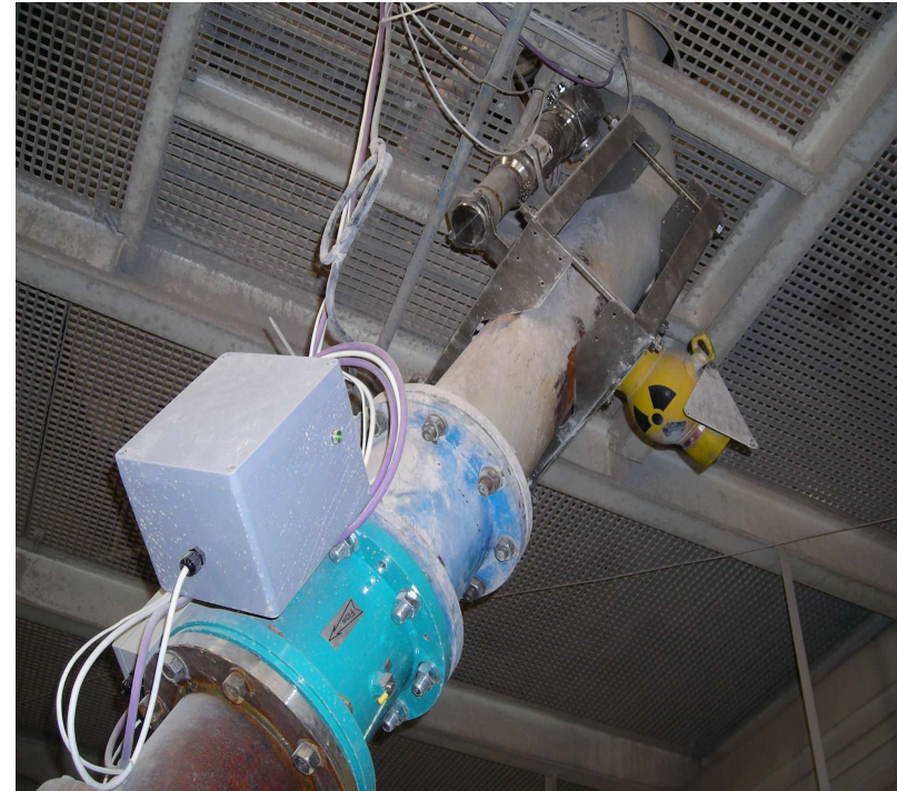
Rys.11. Zespół urządzeń - pomiar przepływu i gęstości [9]
