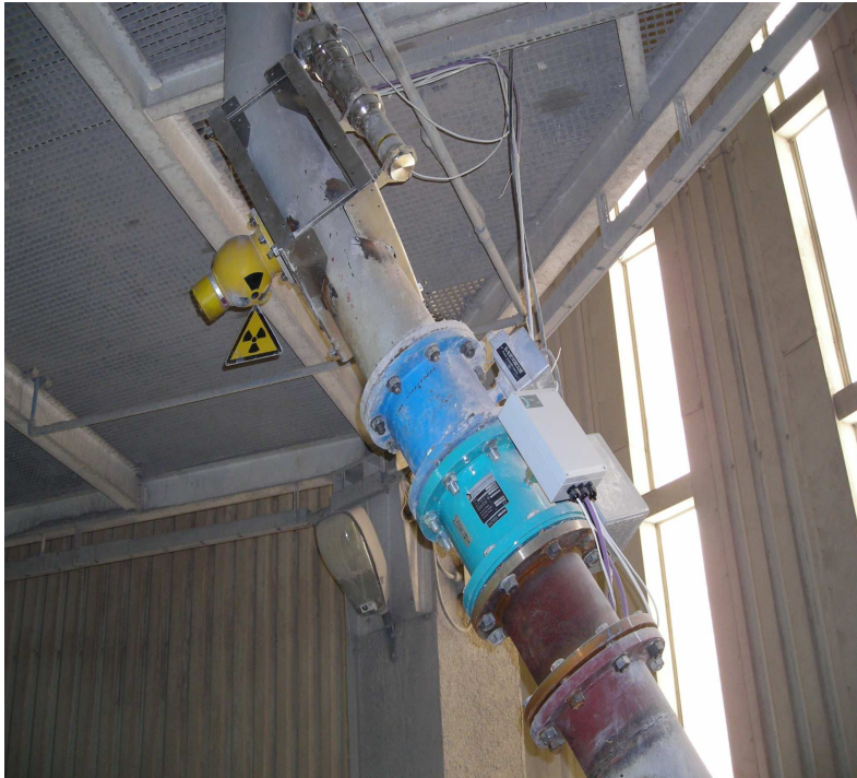
Rys.11. Zespół urządzeń - pomiar przepływu i gęstości [9]
