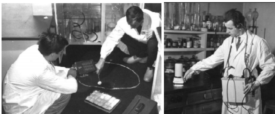
Fot 3 Pomiary skażeń promieniotwórczych w pracowni izotopowej.
