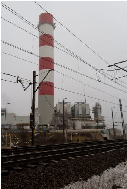
Rys. IChTJ 5.9 Widok ogólny na instalację oczyszczania spalin
