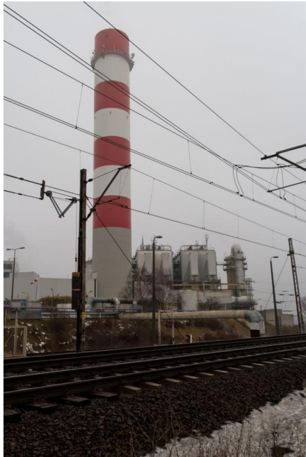
Rys. IChTJ 5.9 Widok ogólny na instalację oczyszczania spalin
