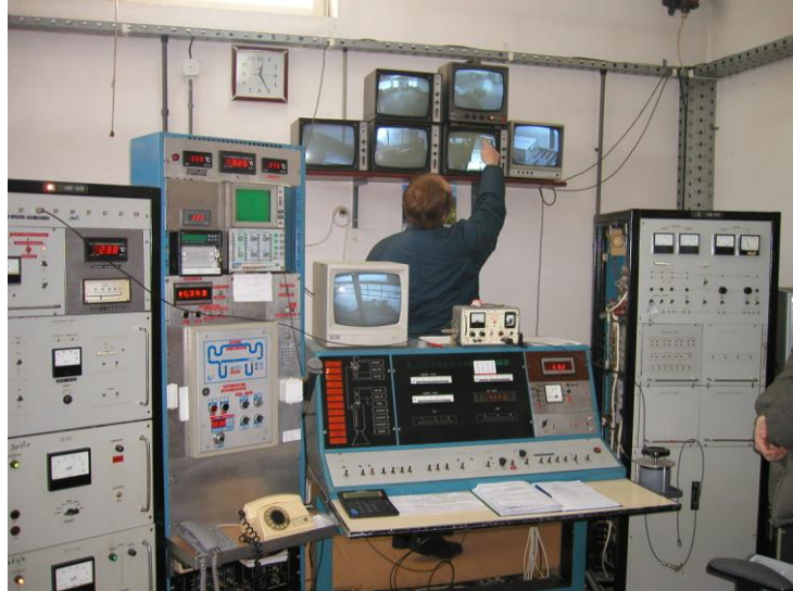
Rys. IChTJ 5.4 Sterownia akceleratora Elektronika 10/10
