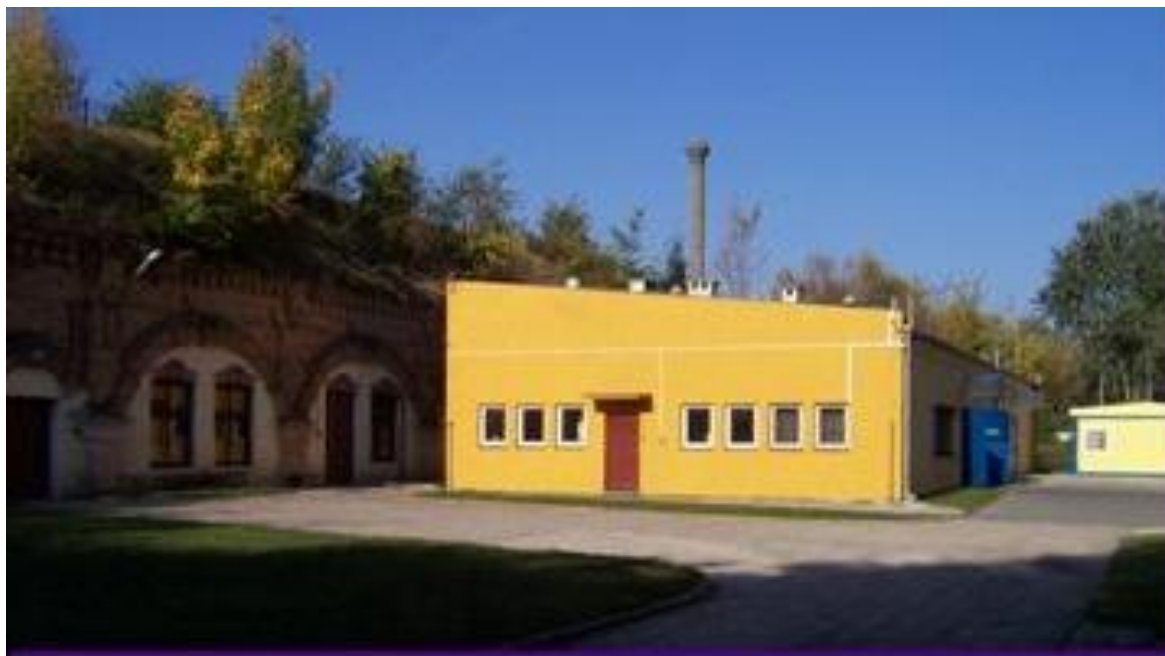
Rys. IChTJ 5.5 Stacja Radiacyjnego Utrwalania Płodów Rolnych – Warszawa Włochy
