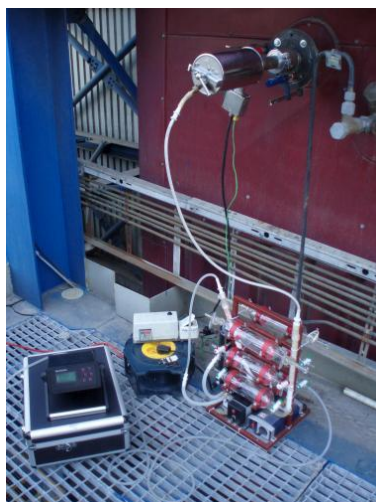
Rys. IChTJ 3.9.1 Pobór prób gazowych z instalacji kotła fluidalnego. Na zdjęciu widoczny jest: miernik koncentracji gazów, grzana sonda i połowy zestaw do poboru prób gazowych.
