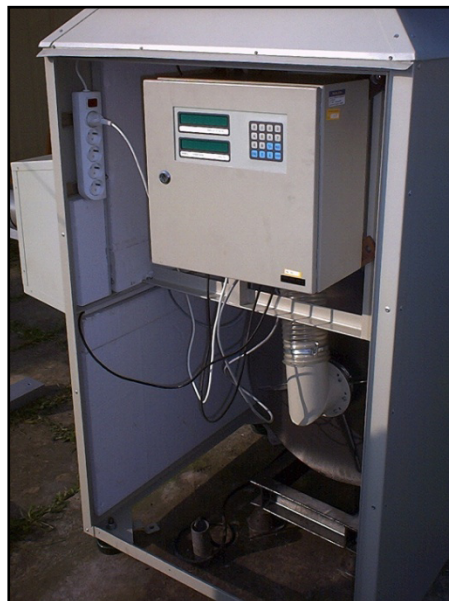
Rys. CLOR-7. Sterownik AS-01 obsługujący sondę scyntylacyjną – sterownik umieszczony jest w stacji ASS-500 (element systemu on-line)
