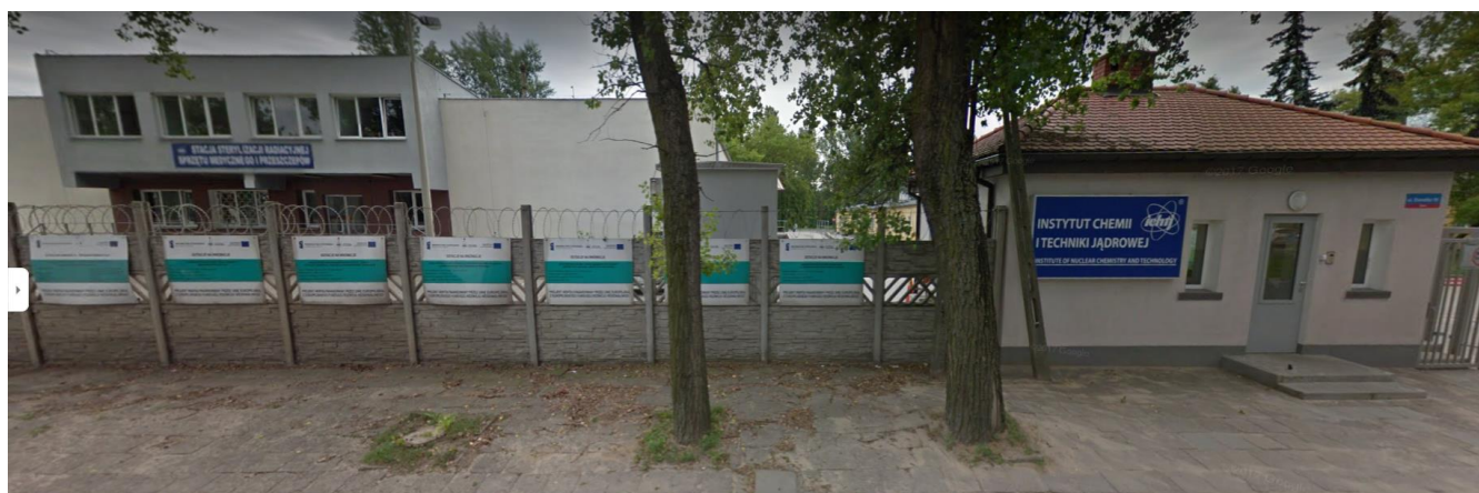
Rys. 7 Zdjęcie przedstawiające wejście do IChTJ od ul. Dorodnej 16 w Warszawie wraz ze znajdującą się po lewej stronie Stacją Sterylizacji Sprzętu Medycznego i Przeszczepów.[7]
