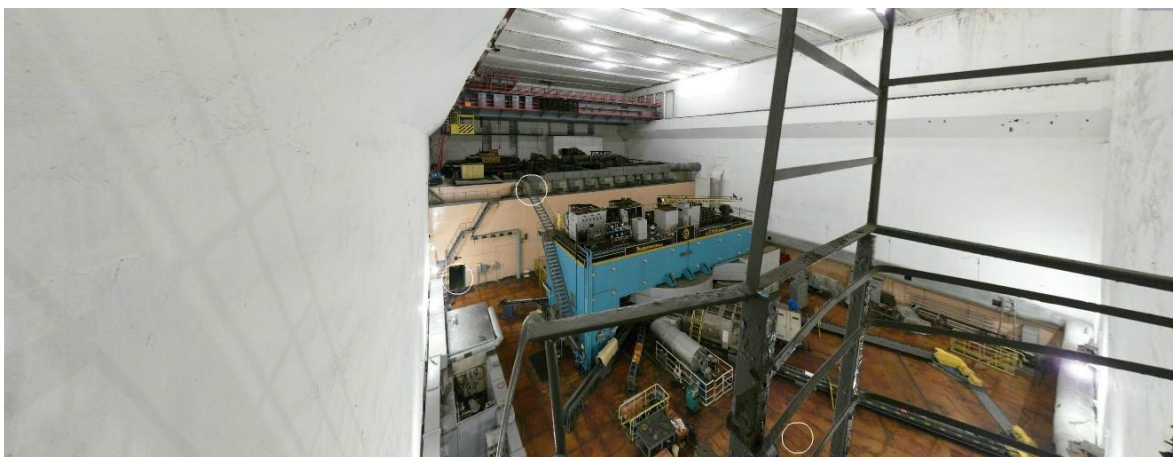
Rys. 20, 21, 22. Zdjęcia wykonane na hali, w której znajduje się fazotron [1. konwerter częstotliwości; 2. uzwojenia elektromagnesu; 3. pompa dyfuzyjna; 4. rama elektromagnesu] [11]
