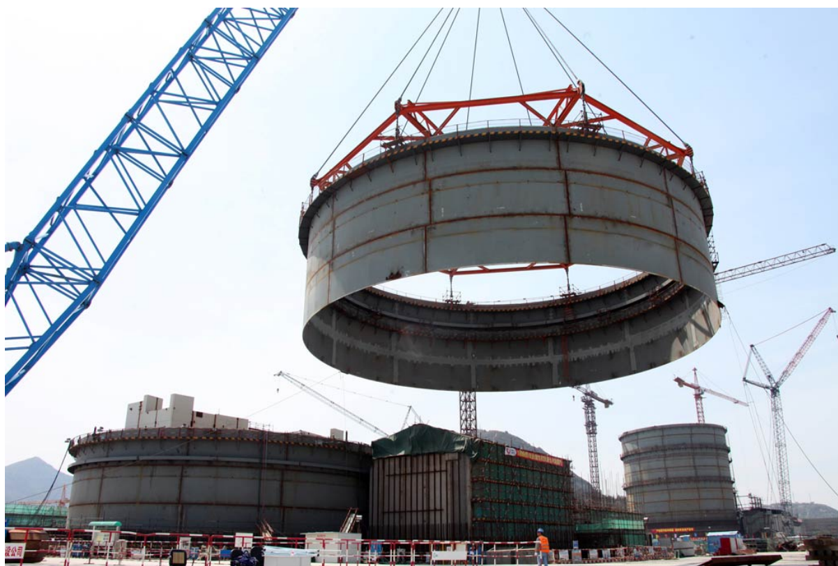
Rysunek 3.6: Budowa AP1000 w Sanmen. Stan na: 09.11 ( http://www.chinatechgadget.com )
