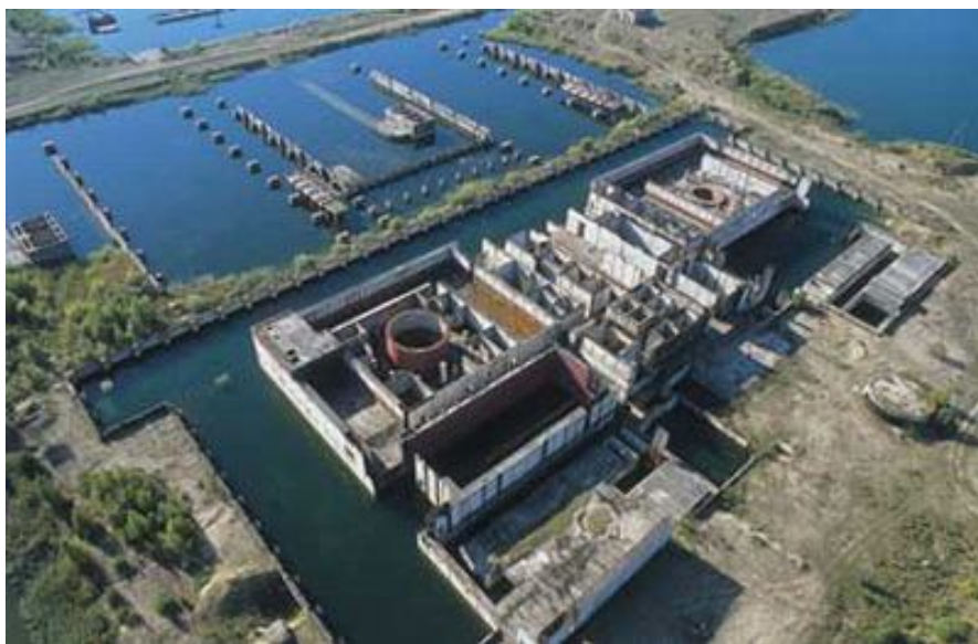
Rysunek 9 - Elektrownia w Żarnowcu stan dzisiejszy [12].
