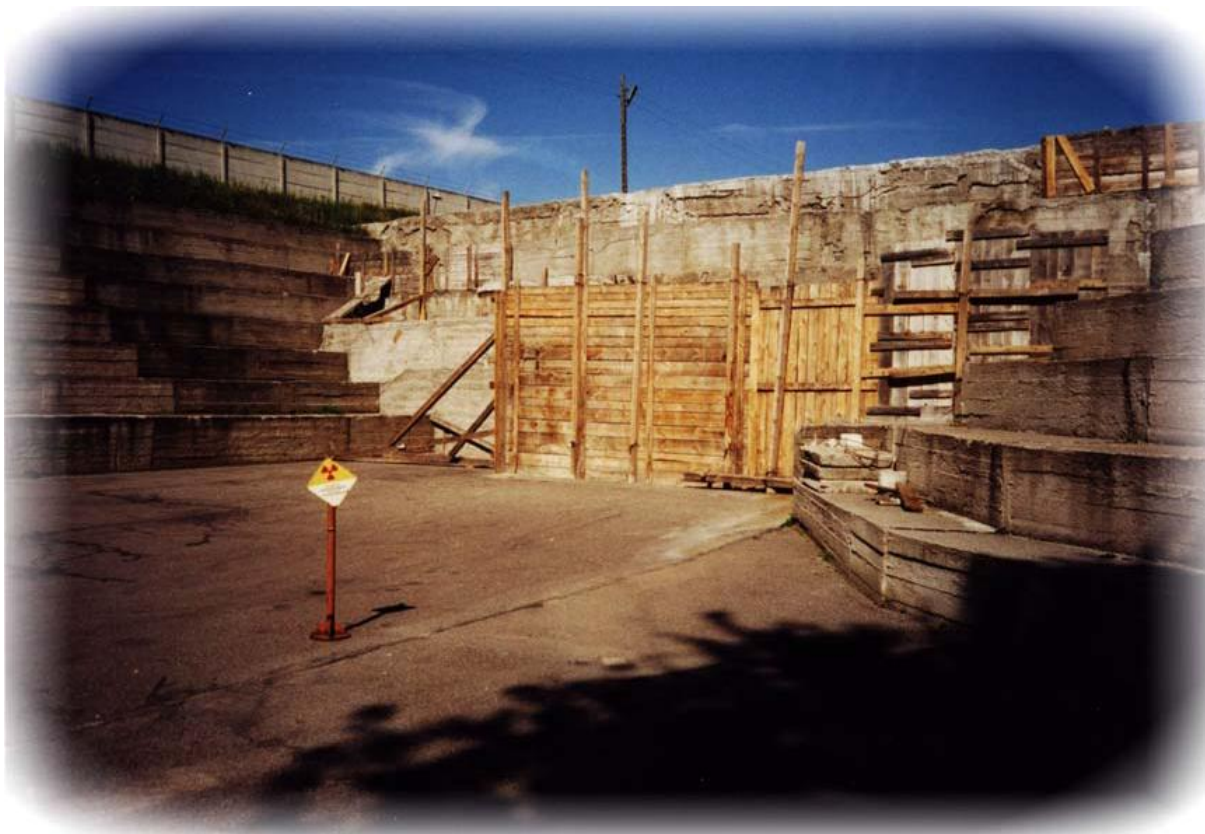
Rys. 8. Fragment fosy w Krajowym Składowisku Odpadów Promieniotwórczych w Różanie. Część fosy jest już wypełniona i zamknięta pionową ścianą betonową.
